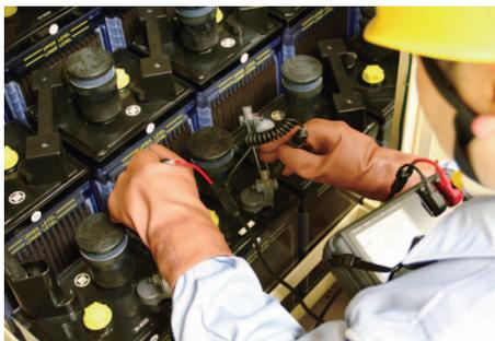
二次电池反复充放电，会导致电池劣化与内阻增大。可能会发生由内部电池短路等故障造成的电压下降、电池自身发热现象、甚至因电池腐蚀短路而引发威胁生命安全的火灾。
